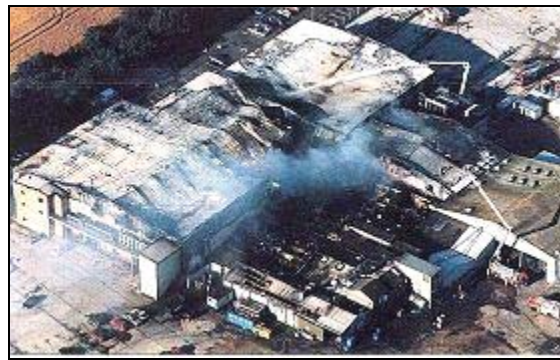
Incendios en industrias cárnicas (matadero y sala de despiece) con paneles sandwich
