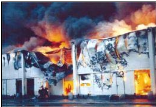
Incendios en industrias cárnicas (matadero y sala de despiece) con paneles sandwich
