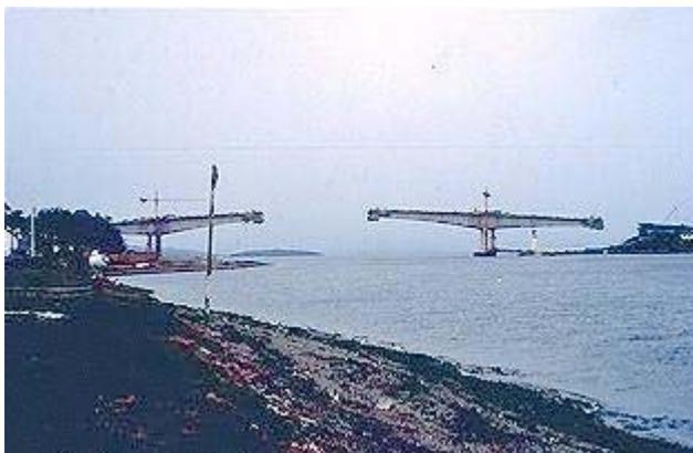
mundial. Permite un auténtico trabajo en secciones. La construcción en voladizo ha probado ser muy eficiente si hay que puentear obstáculos muy anchos o valles profundos, habiéndose alcanzado luces libres de hasta 240 m.
