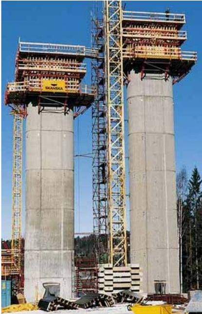
Encofrado deslizante para la construcción de las pilas de un puente
