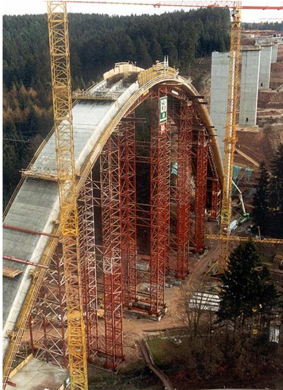
La forma de los puentes de hormigón se obtiene por medio de encofrados en los que se coloca el hormigón fresco (hormigonado in situ). La forma del encofrado para las vigas y las losas de la calzada se apoyan en las llamadas cimbras que transmiten el peso del hormigón aún no portante en el subsuelo. A medida que va fraguándose el hormigón, la obra adopta su propia capacidad de soporte y puede ser retirada la cimbra.
