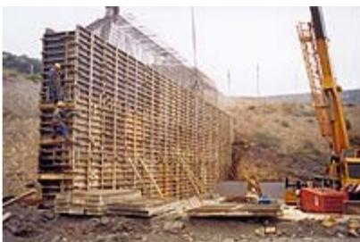
Los encofrados pueden ser **fijos** para ser retirados a posteriori y que, cuando es necesario, se apoya en estructuras metálicas provisionales denominadas cimbrado o **deslizantes**, que se emplean en obras donde la estructura de hormigón es de gran longitud (tableros de puentes, chimeneas de gran altura, núcleos de edificios, etc.) y que van desplazándose gradualmente a una velocidad determinada apoyándose en la propia estructura que se va creando mediante el vertido.
